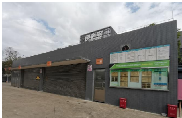
图 3-4o 危险废物暂存点
