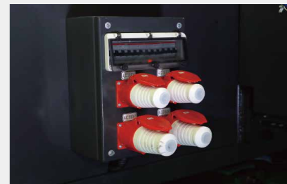
Дополнительные электрические розетки для подключения вспомогательного оборудования
